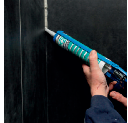
6. Eck-, Anschluss- und Bewegungsfugen elastisch schließen.
