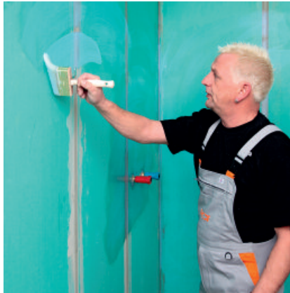
1. Grundierung PCI Gisogrund flächendeckend auftragen.
