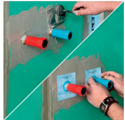
2c. Auch zum Abdichten der Wasserzuleitungen mit der Dichtmanschette PCI Pectape 10 x 10 wird zunächst ausreichend viel Abdichtungsmaterial PCI Lastogum vorgelegt. 2d. PCI Pectape 10 x 10 über den aus der Wand herausstehenden Rohranschluss stülpen und mit PCI Lastogum verkleben.
