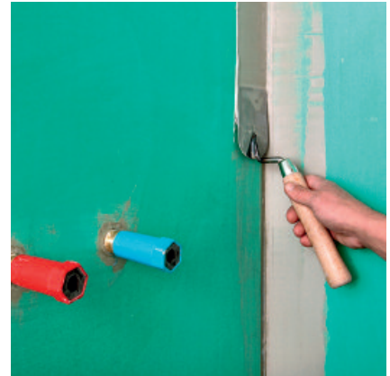
2a. Vor dem Ausführen der Wand-Bodenanschlüsse ausreichend viel Abdichtungsmaterial PCI Lastogum auftragen.
