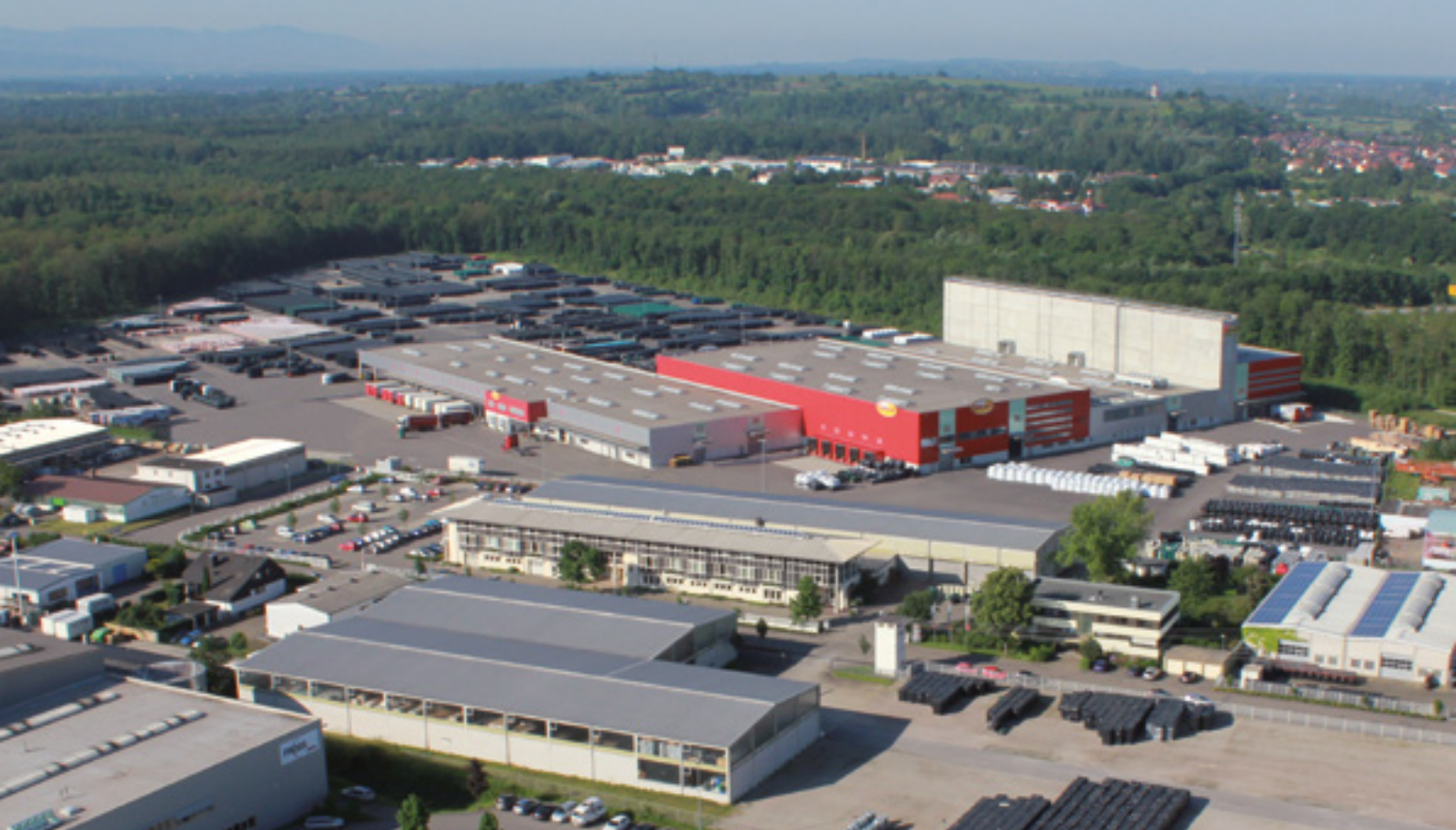
Werk Teningen bei Freiburg
