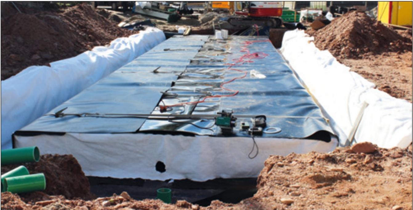
Werkseitig können eingeschweißte Rigolen bis zu einer Breite von ca. 2,40 m und einer Länge von ca. 15 m produziert werden und per LKW zum Einsatzort transportiert werden. Die werkseitigen Rigolen lassen sich vorkonfektionieren
