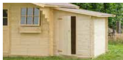
Anbau 3 Seiten geschlossen
