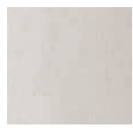
Sichtbeton (Schalungsglatte Beton, Rücken geglättet)
