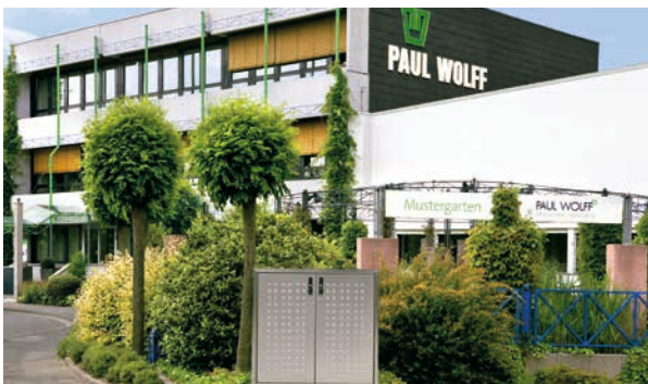
Das Unternehmen PAUL WOLFF an seinem Standort in Mönchengladbach
