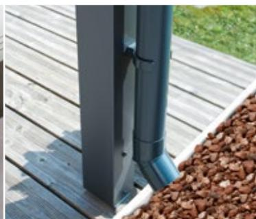
▲ Fallrohr am oder im Pfosten
