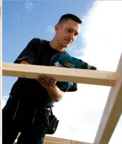
▲ Die Sparren werden laut Aufbauanleitung ausgerichtet und mit Schrauben fixiert. Die Dachkonstruktion wird durch Setzen der Dachlattung vervollständigt.
