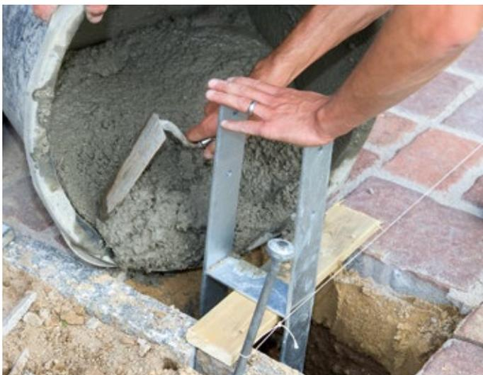
▲ Für genügend Stabilität werden die Pfostenanker in den zu erstellenden Fundamenten ausgerichtet und einbetoniert.
