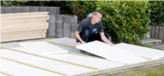
▲ Zunächst wird ein stabiles Fundament erstellt. Die Isolierung des Fußbodens ist bauseits möglich (Dämmdicke 5 cm).
