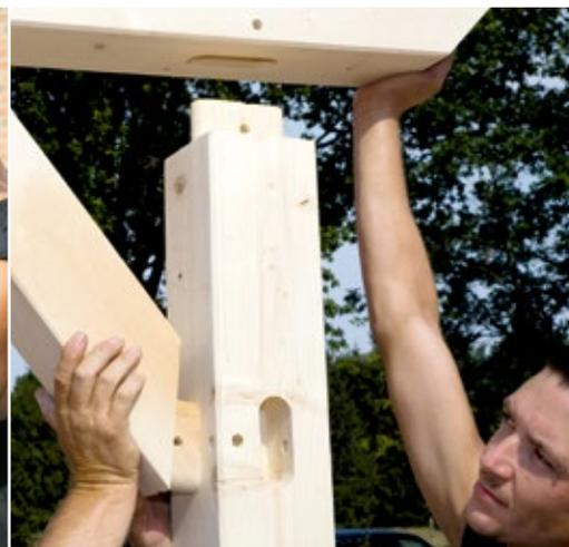
▲ Durch die passgenauen Schnitte und Ausfräsungen ist der Aufbau der nummerierten Einzelteile ganz einfach.
