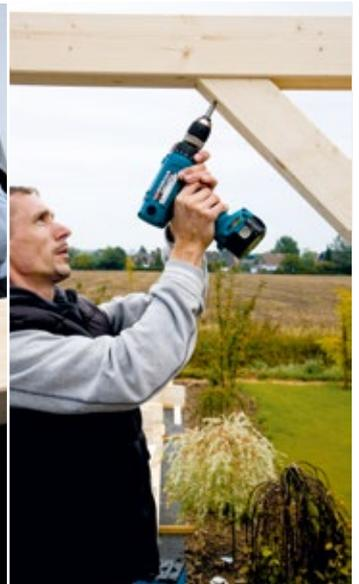
▲ Die Aufschraubstützen werden laut Fundamentplan ausgerichtet und aufgeschraubt.
