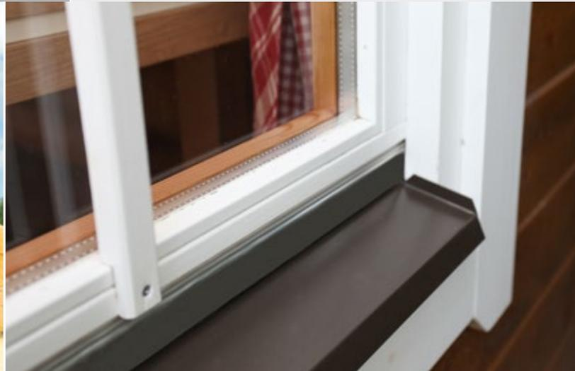
▲ Fensterrahmen aus Leimholz mit aufgesetztem Sprossenrahmen, Fenster mit Isolierverglasung und Aluminium-Abtropfkante
