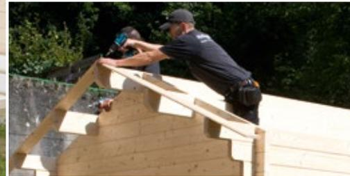
▲ Nach Einsetzen der Pfetten, die mit den Giebelbohlen verschraubt werden, erfolgt das Aufbringen der Dachschalung.
