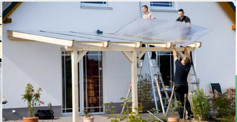
▲ Auf dem Sparren wird das Unterlegband mit Dachnägeln befestigt. Die Doppelstegplatten werden für die Montage vorbereitet und auf das Dach gelegt. Die Befestigung der Dachplatten erfolgt durch Aufschrauben der Aluminiumabdeckprofile. Und fertig!
