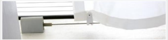
▲ Befestigung Sonnensegel: Seilspannsystem mit Schutzkappe
