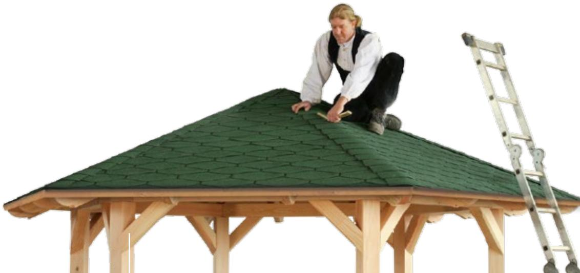
▲ Den Abschluss bildet das Verlegen der Dachschindeln (optional als Zubehör erhältlich). Fertig!
