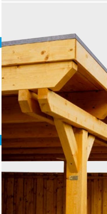
▲ Emsland, Holzblende mit Abschluss; Konstruktion mit Doppelfette
