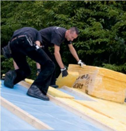
▲ Nach der Dachschalung erfolgt die Montage der gegebenenfalls zusätzlichen Dachteile. Eine Dämmung ist optional möglich.
