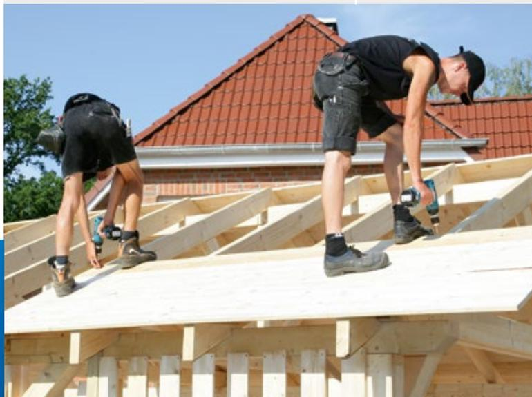
▲ Die Dachbretter werden mit den Sparren verschraubt.
