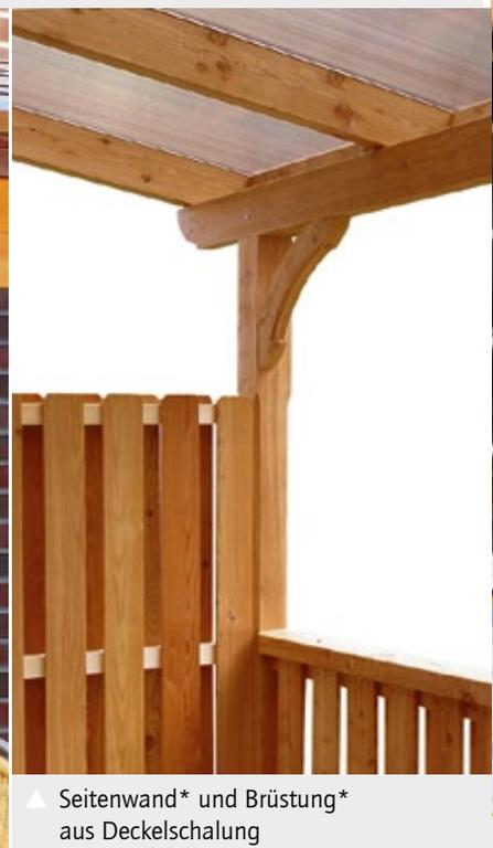
▲ Seitenwand\* und Brüstung\* aus Deckelschalung
