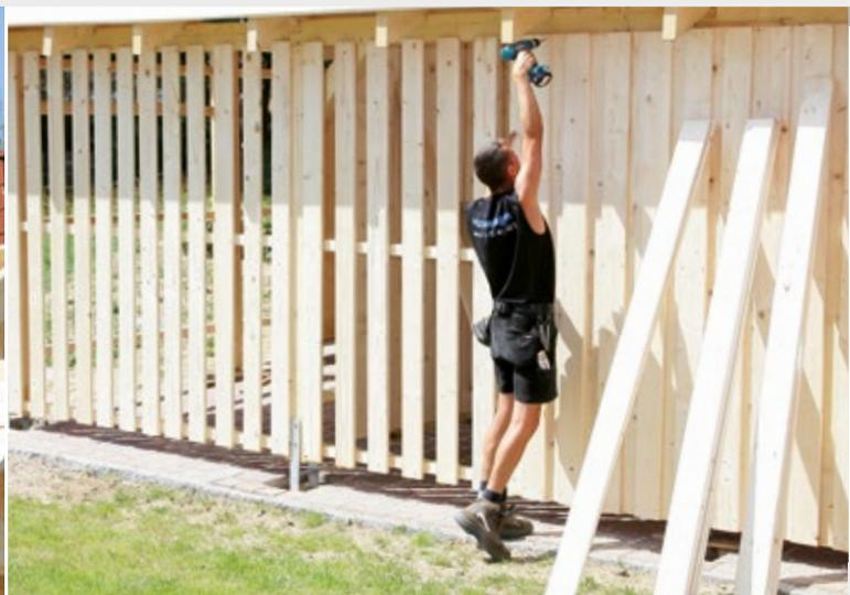
▲ Abstellraum und Wände bestehen aus Riegeln und Brettern, welche als Deckelschalung verschraubt werden.
