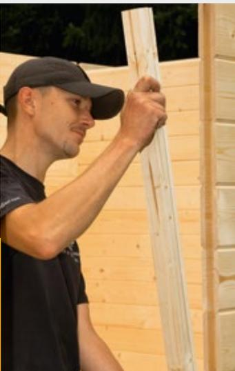
▲ Der Einbau der isolierverglasten Fenster und Türen erfolgt mit in den Blockbohlen eingelassenen Gleitleisten (bei 45plus und 70plus). Die Fenster sind mit Aluminium-Abtropfblechen ausgestattet.
