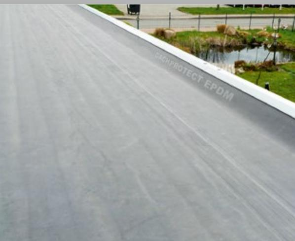
▲ EPDM-Folie (Ethylen-Propylen-Dien-Terpolymer, 100 % vernetztes, synthetisches Gummi)
