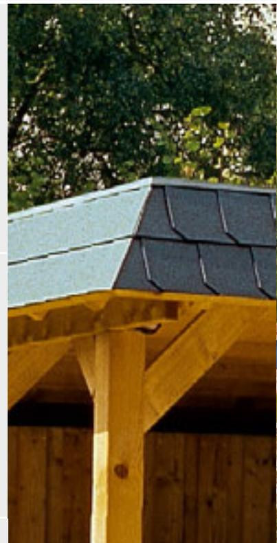
▲ Dachkante mit Aluminium-Schiene
