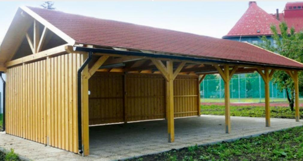
▲ Satteldach-Anlage mit Dachschindeln
