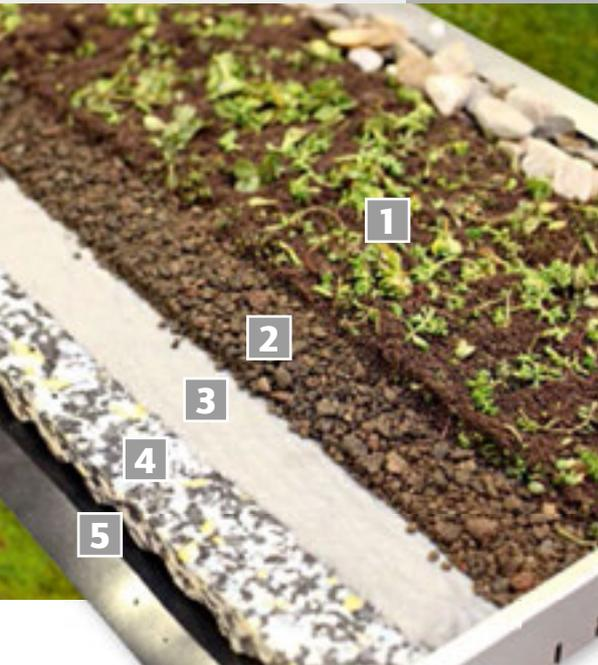
▲ Beispielhafter Querschnitt durch die Dachbegrünung
