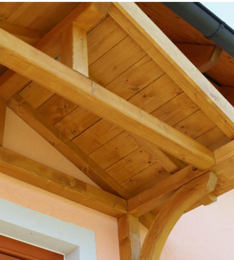
▲ Design-Vordach Stettin, Detailansicht Dachkonstruktion
