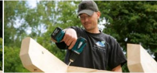
▲ Nach Einsetzen der Pfetten, die mit den Giebelbohlen verschraubt werden, erfolgt das Aufbringen der Dachschalung.
