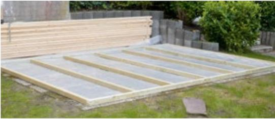
▲ Zunächst wird ein stabiles Fundament erstellt. Die Isolierung des Fußbodens ist bauseits möglich (Dämmdicke 5 cm).
