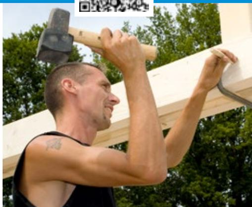
▲ Die Zapfen werden in die Zapfenlöcher gesteckt und mit einem Holznagel verbunden.
