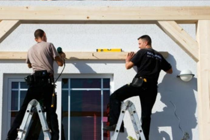
▲ Die hintere Pfette zur Wandbefestigung wird gemäß der Aufbauanleitung positioniert und mit Hilfe des Wandbefestigungssets (Zubehör, optional) fest montiert.
