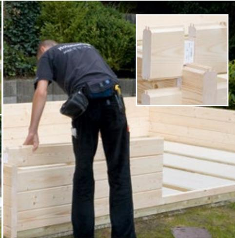
▲ Die Blockbohlen werden ineinander gesteckt und durch verdeckte liegende Gewindestangen für Sturmsicherung verbunden.
