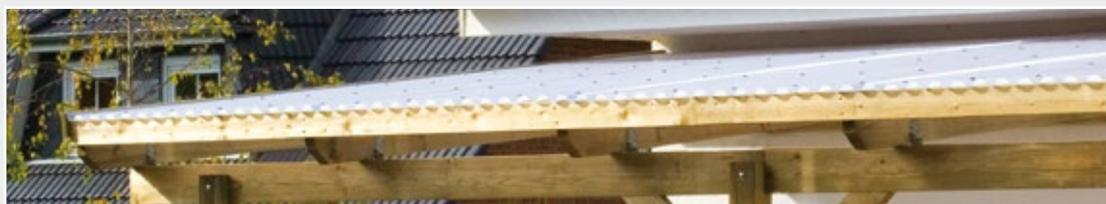
▲ Pisa, Dacheindeckung aus Kunststoffplatten, milchig mit Trapezprofil
