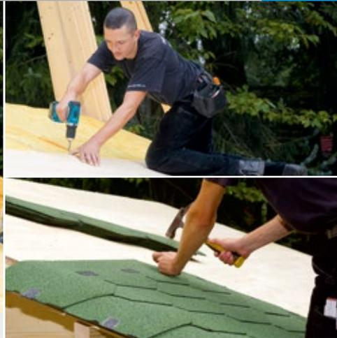
▲ Nun erfolgt die Eindeckung des Daches. Eine Lage Dachpappe inkl. Befestigung ist enthalten, Schindeln sind optional erhältlich.
