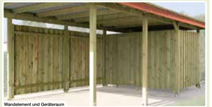
Wandelement und Geräteraum
