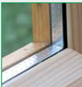
Isolierverglasung zum Schutz vor Kälte ab 44 mm Bohlenstärke
