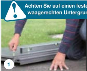
**1** Bodenplatte mittels Stellfüßen in waage bringen.
