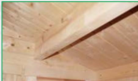
Stabile Dachpfetten; Dachbelastbarkeit über 180 kg/m<sup>2</sup>
