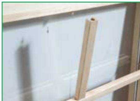
Clips zum einfachen Lösen der Sprossen
