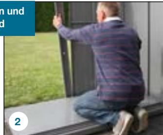
**2** Anbringen/Verschrauben der rechten Rückwand mit der Verbindungsleiste.
