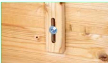
**Sturmleisten** (bei Wandstärken 28/34/40 mm) sichern das Vordach
