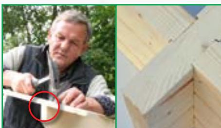
Optimale Auflage der Dachbretter durch abgeschrägte Seitenwandbohle
