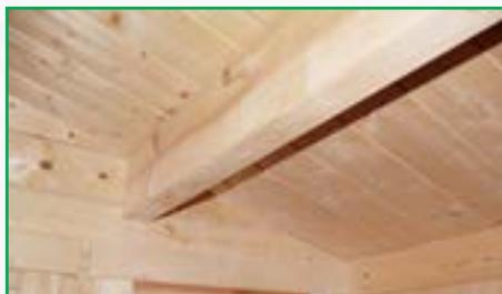
Stabile Dachpfetten; Dachbelastbarkeit über 180 kg/m<sup>2</sup>
