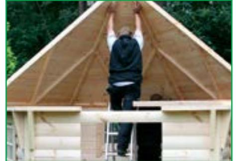
Vorgefertigte fertig geschindelte Dachelemente für eine passgenaue Montage
