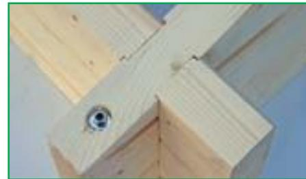
Obere Wandbohle abgeschrägt, hierdurch optimale Auflage der Dachbretter
