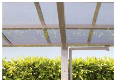
Flexible Positionierung des Fallrohrs
