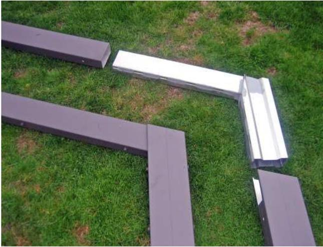
**Bild 2:** Positionieren der Bodenträger
