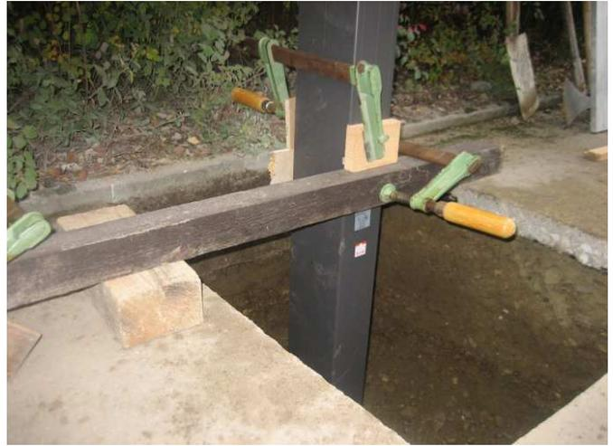
**Bild 3 + 4:** Montage der vorderen und hinteren Längsträger (Ausrichten)
