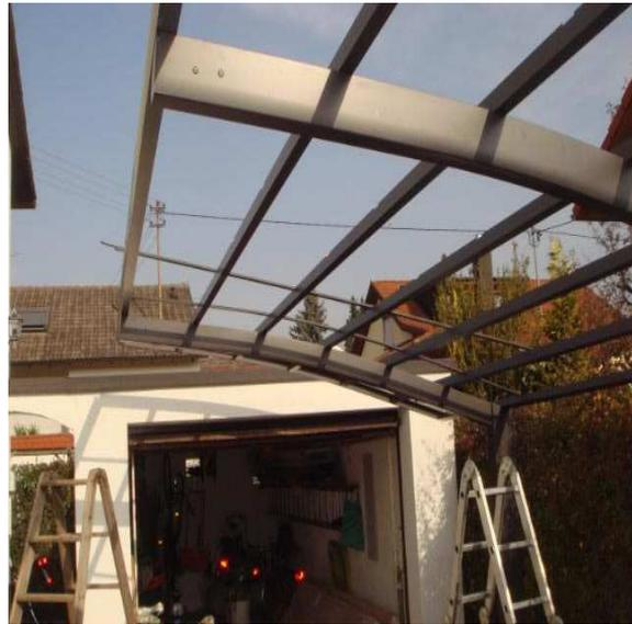
**Bild 9 + 10:** Montage der Querleisten
