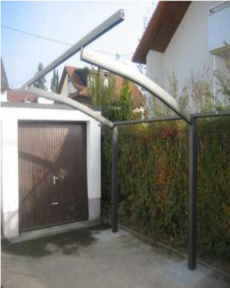
**Bild 8:** Montage der Längsleisten
