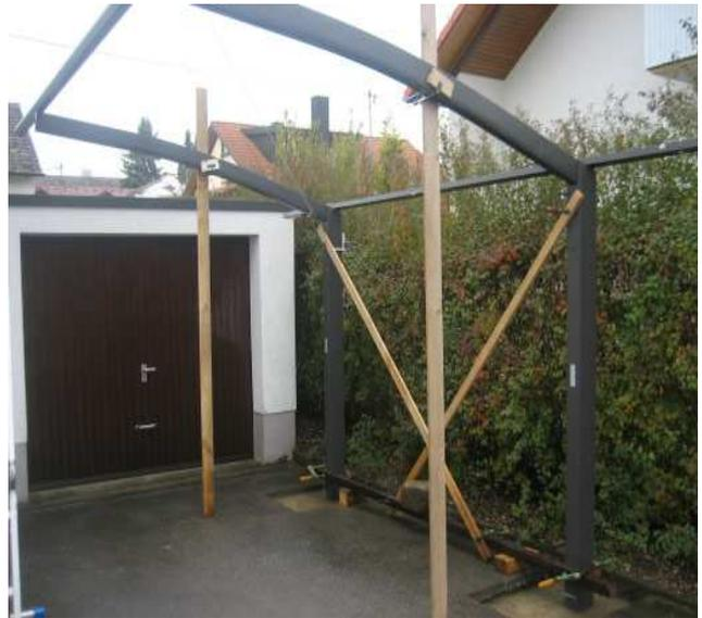
**Bild 5 + 6:** Beton einbringen und ca. 2 Tage aushärten lassen
