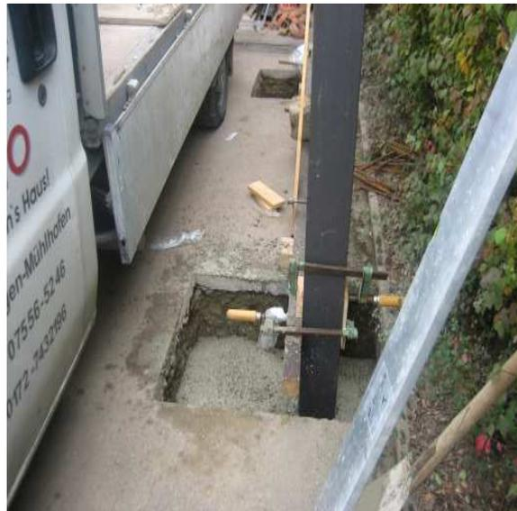
**Bild 7:** Beton ausgehärtet und Stützen entfernt
