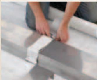
Legen Sie die Elemente auf den Kopf gedreht passend aneinander. Dann wird der Verbindungsstreifen aufgeklebt.
