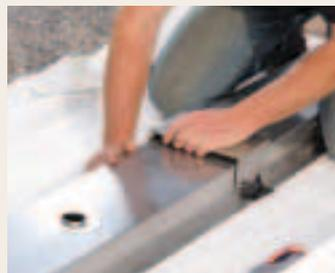
Das Edelstahl-Verbindungselement wird dann aufgesetzt und mit Hilfe von acht Muttern und Unterlegschrauben verbunden. Drehen Sie dann – am Besten zu zweit – den komplett verschraubten Bachlauf auf die richtige Seite.
