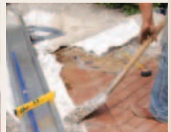
Ganz wichtig ist die waagerechte Ausrichtung des Systems – prüfen Sie unbedingt in beide Richtungen, ob die Bachlaufelemente in Waage sind. Danach kann die Randgestaltung vorgenommen werden – fertig!
