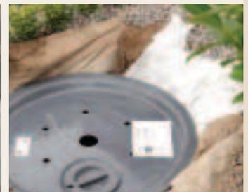
Das Wasserreservoir wird idealerweise am Kopfende des Startelements platziert und sollte versteckbar, aber zugänglich sein. Die Schläuche werden einfach entlang der Bachlaufelemente in das Kiesbett verlegt.
