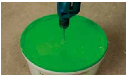
Loch in Deckel bohren, bei geschlossenem Eimer trocken durchmischen
