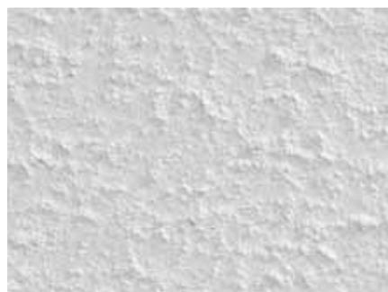
Struktur einer gut vorbereiteten Gipskartonplattenfläche
