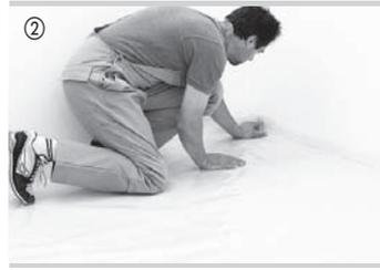
Grundsätzlich ist bei allen Estrichen und bei Verlegung auf Fußbodenheizung eine 0,2 mm starke PE-Folie auszulegen. Diese soll im Stoßbereich 30 cm überlappen. Anschließend die Folie im Wandbereich hochziehen und nach der Sockelleistenmontage an der Oberkante abtrennen. **Da der HARO Korkboden bereits eine integrierte Korkdämmunterlage besitzt, darf keine zusätzliche Dämmunterlage ausgelegt werden.**
