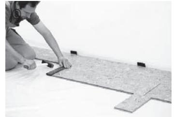
Nun kann das Element mit Hammer und Schlagklotz waagrecht eingeklickt werden. Zur leichteren Verlegung der Elemente im Stirnbereich empfiehlt sich die Verwendung eines elementübergreifenden Anschnitts im Längskantenbereich.
