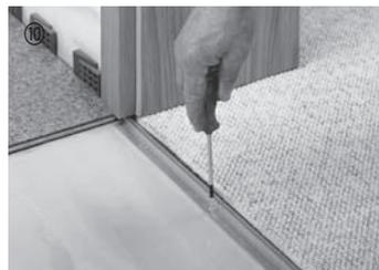
Zur Einhaltung des Dehnungsabstandes muss bei Türübergängen stets ein geeignetes Profilsystem eingesetzt werden. Dies gilt auch, wenn im angrenzenden Raum der gleiche Boden verlegt werden soll. In diesem Fall ist für die Einhaltung der Dehnungsfuge ein Übergangprofil einzusetzen. In der Schiene ist ein Dehnungsabstand von ca. 5 mm einzuhalten. Grundsätzlich müssen Holzürstücker in Bodenelementdicke mit einer Feinsäge abgeschnitten werden, damit der Korkboden eine Dehnungsmöglichkeit hat.
