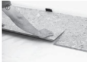
Zunächst wird das Element längsseitig in die Verbindung eingeführt und stirnseitig bündig an die zuvor liegende Elementkante geschoben. Jetzt kann dieses Element längsseitig abgesenkt werden.
