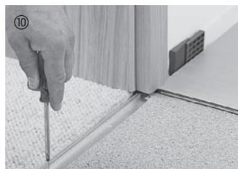
Zur Einhaltung des Dehnungsabstandes muss bei Türübergängen stets ein geeignetes Profilsystem eingesetzt werden. Dies gilt auch, wenn im angrenzenden Raum der gleiche Boden verlegt werden soll. In diesem Fall ist für die Einhaltung der Dehnungsfuge ein Übergangprofil einzusetzen. In der Schiene ist ein Dehnungsabstand von ca. 5 mm einzuhalten. Grundsätzlich müssen Holzstückchen in Parkettelementdicke mit einer Feinsäge abgeschnitten werden, damit das Parkett eine Dehnungsmöglichkeit hat.
