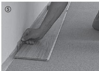
In der rechten Raumecke beginnend, wird das erste Element verlegt und mit Keilen fixiert (Dehnungsabstand zur Wand 10–15 mm). Die Elemente werden stets mit der Federseite zur Wand verlegt.
