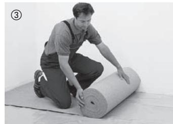
Zur Trittschalldämmung und zum Ausgleich kleiner Unebenheiten wird eine 2 mm dicke Korkdämmunterlage bündig ausgerollt. Alternative Dämmunterlagen finden Sie in unserem Zubehörangebot. Bitumenpappe und Teppichboden eignet sich nicht zur Trittschalldämmung. **Parkettboden mit aufkaschierter Dämmunterlage ist für eine vollflächige Verklebung nicht geeignet.**
