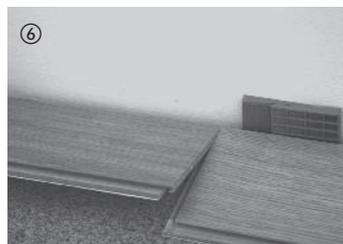
Die weiteren Elemente der ersten Reihe werden stirnseitig mit leichtem Druck in die Verbindung eingeklappt. Achten Sie darauf das zu verlegende Element bis an die Kante des bereits verlegten Elements heran zu führen.
