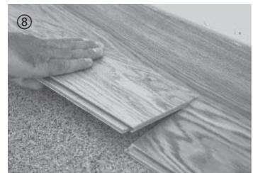
Die weiteren Elemente werden dielenweise verlegt. Dazu werden die Dielen zuerst längsseitig mit leichtem Druck in die Verbindung eingedreht und stirnseitig eingeklappt.
