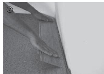
Das letzte Element der ersten Reihe wird, unter Berücksichtigung eines stirnseitigen Dehnungsabstandes von 10–15 mm zur Wand, zugeschnitten und eingefügt. Mit dem Reststück der ersten Reihe wird in der nächsten wieder begonnen. Dadurch wird der Verschnitt erheblich reduziert. Beachten Sie: stirnseitiger Versatz mindestens 50 cm.
