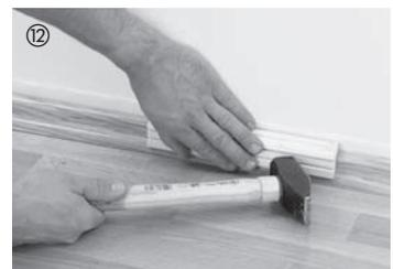
Nach der Verlegung unbedingt die Abstandskeile entfernen. Sockelleisten (mit und ohne Clip-System montierbar) werden an der Wand befestigt – fertig.
