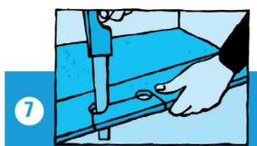
Für Rohranschlüsse werden Löcher gebohrt, deren Durchmesser ca. 20 mm größer sind, als der des Rohres. Nachdem die Diele verlegt ist, wird das Reststück eingesetzt. Die Abdeckung erfolgt nachträglich mit Rosetten.
